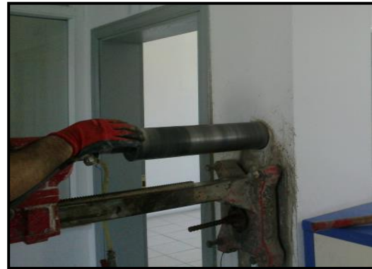
Şekil.1.Yapıdan Karot Numune Alımı (Concrete Core Sampling Of Construction)
