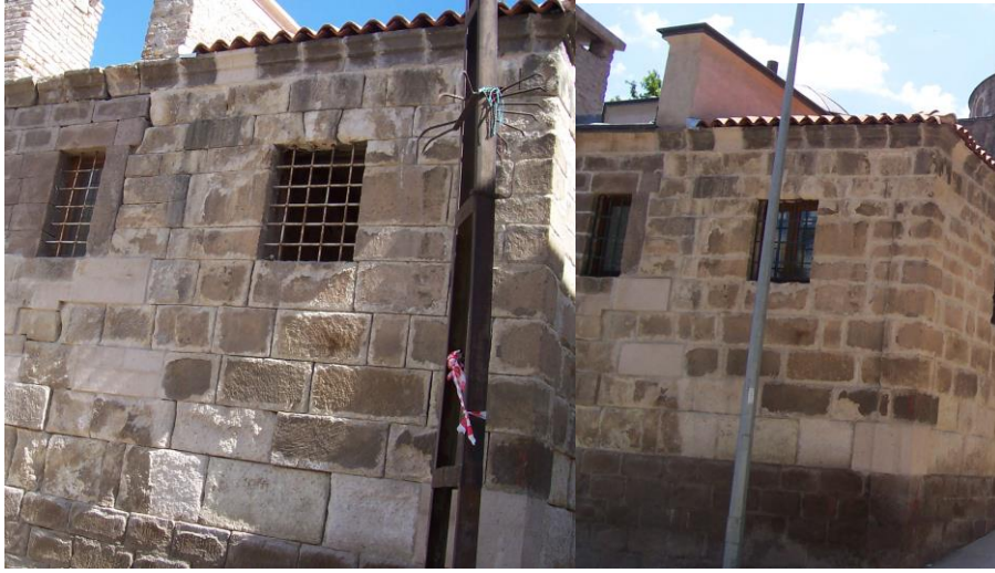
Şekil 6. Mevlevi (Türbe) Cami restorasyon çalışmasında bütünleme işlemi. Taşların derzleri ve ayrılmış kısımları kazınmış ve bu kısımlar derz dolgu malzemesi ile doldurularak sağlamlaştırılmıştır. (Integration process of Mevlevi (Turbe) Mosque restoration which consists of removing joints and separated portions of stones and filling with grouting material).
