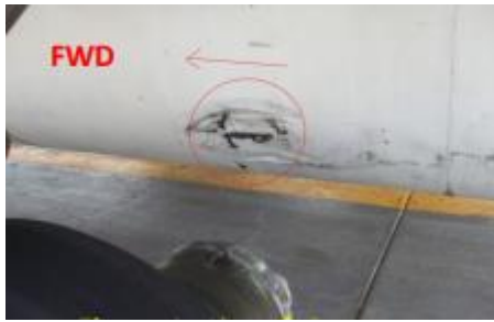
Şekil 6. Kırılan uçak jantının uçak gövde yapısı üzerinde meydana getirdiği hasar [8]
