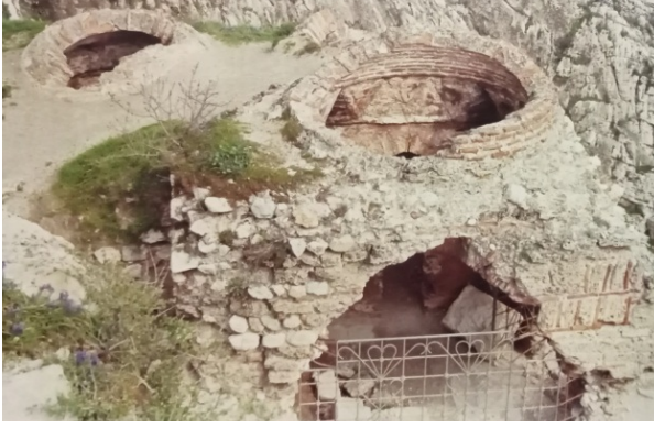
Şekil 26. Onarım öncesi batı cephe
