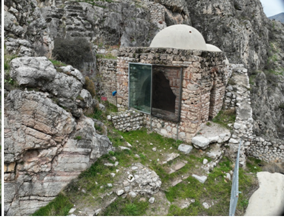
Şekil 4. Batı cephe hamam yolu
