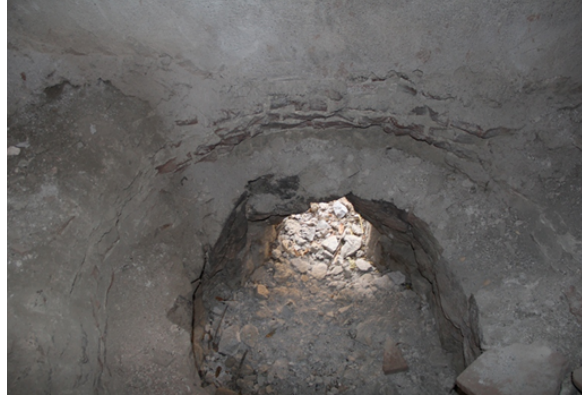
Şekil 22. Sıcak su deposu
