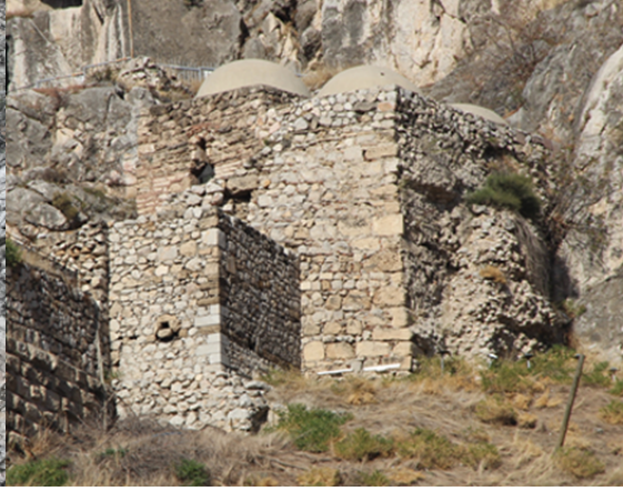
Şekil 6. Güney ve doğu cephe
