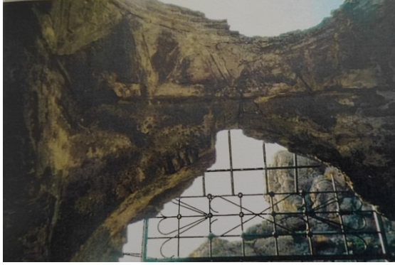
Şekil 28. Soğukluk kubbeye geçişler
