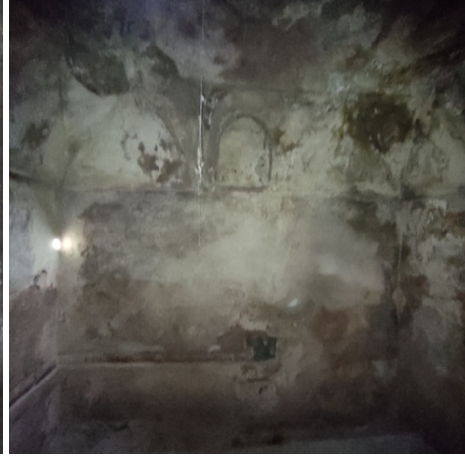
Şekil 18. Sıcaklık güney duvarı
