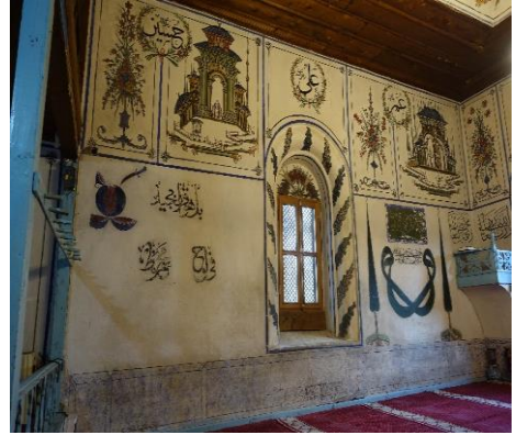
Fotoğraf 12: Harim Doğu Cephesi
