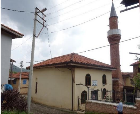
Fotoğraf 3: Kemaliye Köyü Camii Kuzeydoğu Cephesi
