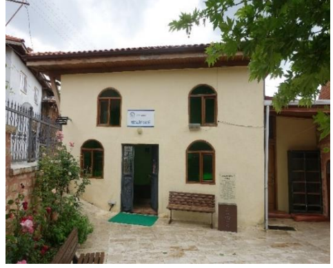
Fotoğraf 2: Kemaliye Köyü Camii Kuzey Cephesi
