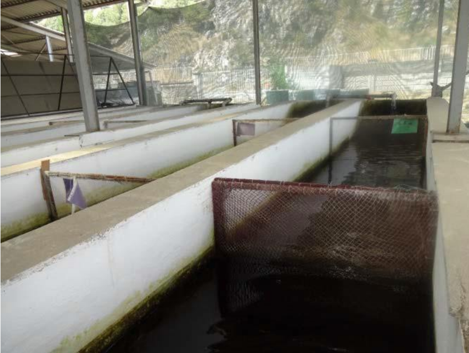
Şekil 1. Süleyman Demirel Üniversitesi Eğirdir Su Ürünleri Fakültesi beton havuzları
