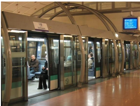
Şekil 25: Paris Lyon Metro İstasyonu (Tam Boy Kapı Sistemi)
