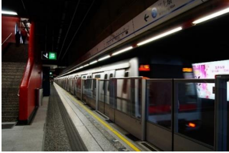
Şekil 23: Hong Kong Heng Fa Chuen Metro İstasyonu (Yarım Boy Kapı Sistemi)
