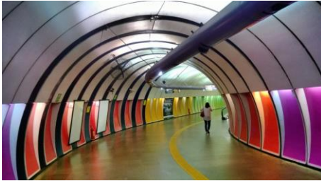
Şekil 8: Rio de Janeiro Copacabana Metro İstasyonu Yatay Dolaşım Alanı
