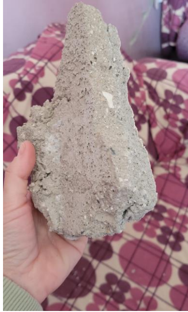
Şekil 15: Kalın sıva uygulaması.
