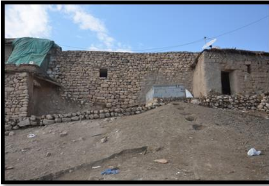
Resim 17: Ortaalan Hanı genel görünüş
