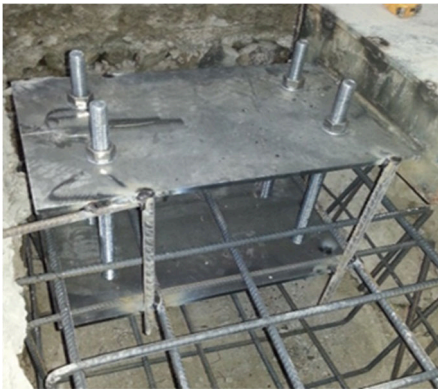
Şekil 4a. Temel beton ankrajı (Concrete anchorage)
