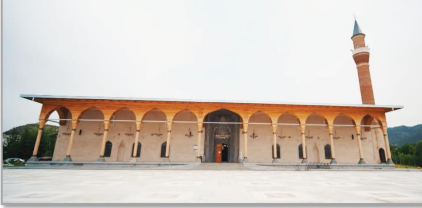
Şekil 11: Afyon Paşa Camii kuzey cephesi 46
