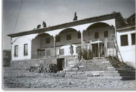
Şekil 4: Afyon Paşa (Umur Bey) Camii'nin doğu girişi ve sonradan eklenen revaklı bölme
