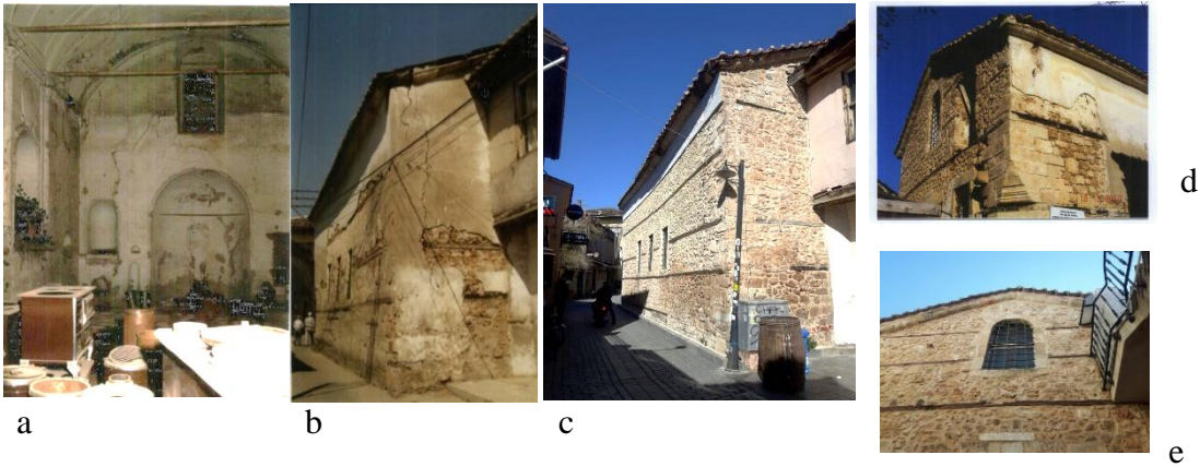
Şekil 11. Aya Alypios Kilisesi onarım öncesi apsiden içerden görünüş (a) ( AKVKBKM, 1990 ), onarım öncesi apsiden dışarıdan görünüşü (b) ( AKVKBKM, 1990 ), onarım sonrası apsiden dışarıdan görünüşü (c) (Orijinal, 2021), giriş cephesi ve Yeni Kapı Sokak cephesi (d) ( AKVKBKM, 1990 ), giriş cephesi (e) (Orijinal, 2021).
