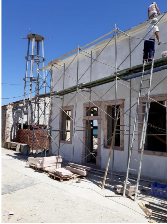
Şekil 25. Tariş Zeytinyağı Fabrikası - Restorasyon Şantiyesi Resimleri (Aytaç 2019).
