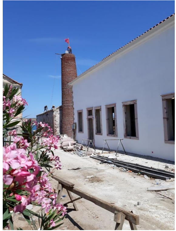
Şekil 26. Tariş Zeytinyağı Fabrikası - Restorasyon Şantiyesi Resimleri (Aytaç 2019).
