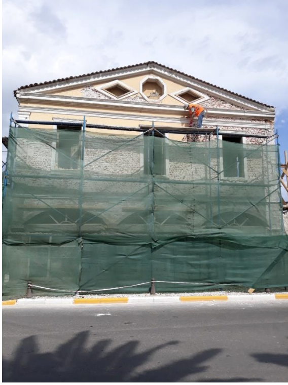
Şekil 23. Tariş Zeytinyağı Fabrikası - Restorasyon Şantiyesi Resimleri (Aytaç 2019).
