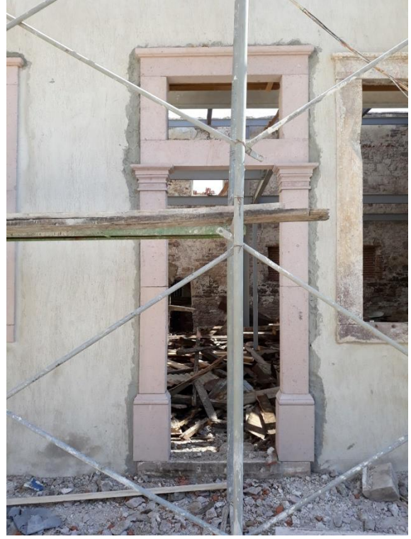
Şekil 24. Tariş Zeytinyağı Fabrikası - Restorasyon Şantiyesi Resimleri (Aytaç 2019).
