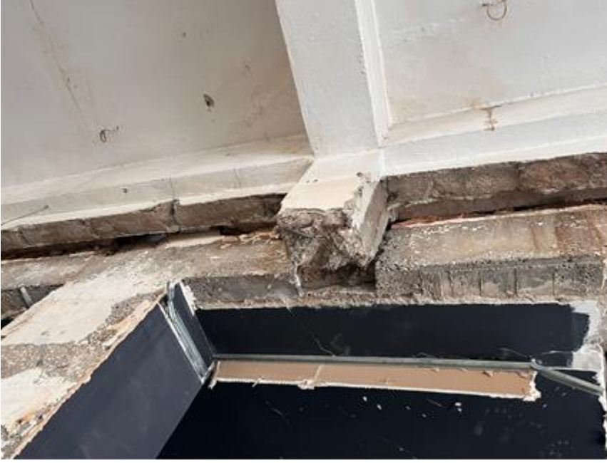
Resim 10. Bitişik nizam bir yapıda, tavan döşemesinden 25cm. sarkan kesilmiş kolon parçası (Kırıkhan'da zemin katta ticari bir işletmenin düşen asma tavanından alınan görüntü)
