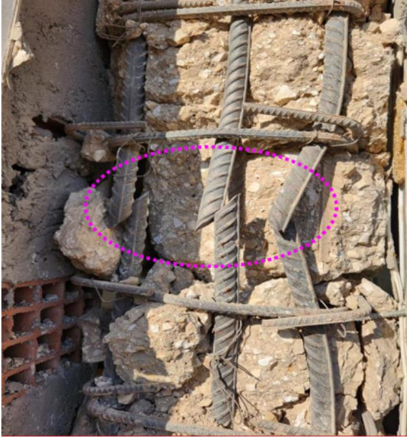
Resim 4. Kesilen kolon donatıları ve 90 derece bükülmüş etriye kancaları (İMO 48. Dönem - Danışma Kurulu 3. Toplantısı sunumları – 14 Ekim 2023 / Adana)
