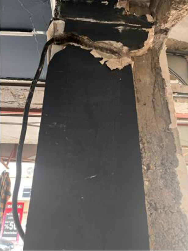
Resim 8. Kırılarak kesiti zayıflatılan, kablo geçirilmiş kolon
