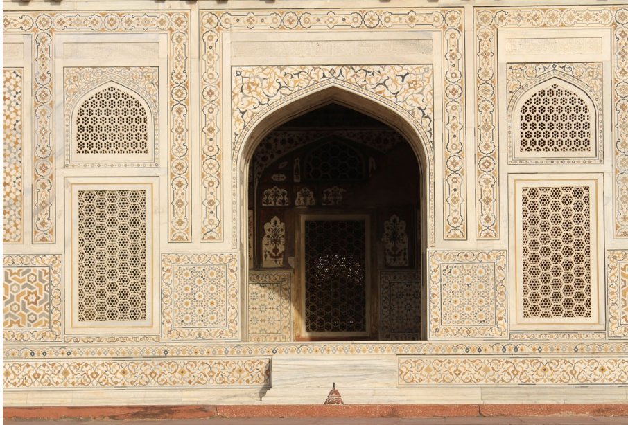
Görsel 14: Giriş Açıklığı Genel Görünüşü (Özler Kaya, 2023)
