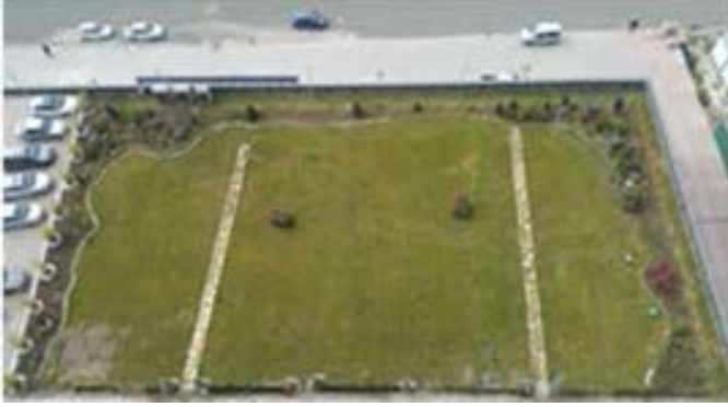
Şekil 11. AP Green Tower çatı bahçesi.
