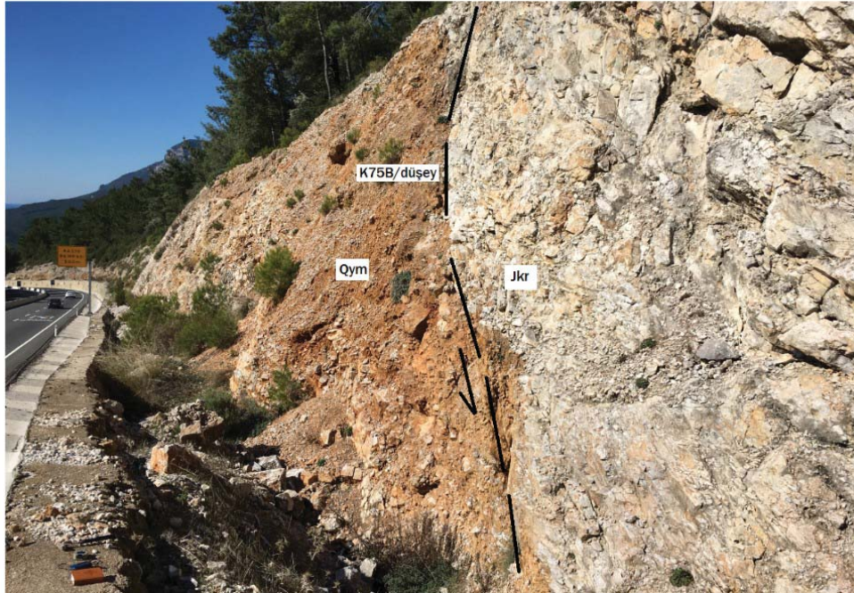
Şekil 10. Muğla yolu üzerinde düşey eğimli fay (BKB'ya bakış)
