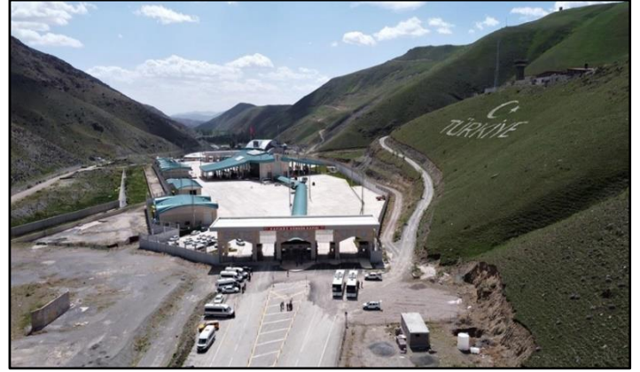
Şekil 12. Kapıköy Gümrük Kapısından Bir Görünüm (URL, 3).
