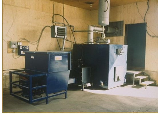
Şekil 7. Kabuk artıkların yakıldığı otomatik beslemeli yakma sistemi. Figure 7. Burning system with automatically feeding in which the shell residues are burnt.
