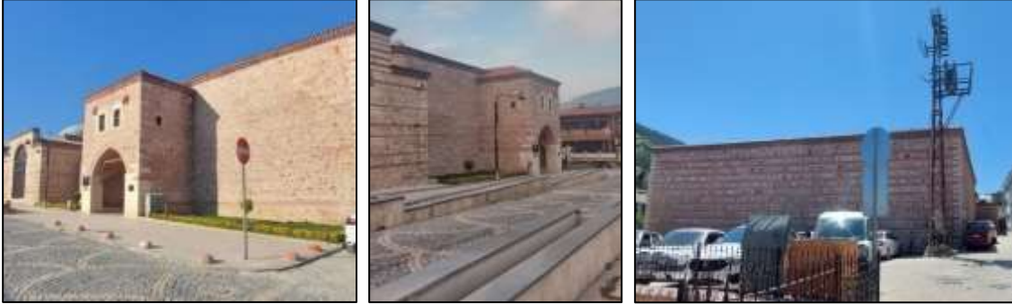
Şekil 37: Restore Edilen Yapının Özgün Taş Duvarları 100
