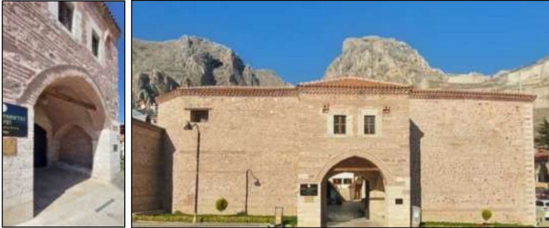
Şekil 24: Yapının Güney Cephesinde Eyvan Tarzındaki Taç Kapısının Sağ Üst Kısmında Saçak Altında Tuğla Malzemeden Yapılan Kuş Evi 83
