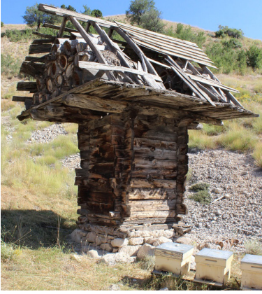
Fot. 8: Ahşap gövdeli moloz taş dolgulu arı evi, Dereköy-Kumluca, Antalya, genel görünüm ve perspektif görünüş.
