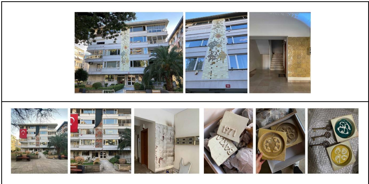
Görsel 5. Prenses Palas Apartmanı Yıkılmadan Önce (Hakan, kişisel arşiv, 2022b) ve Yıkıldıktan Sonra (Hakan, kişisel arşiv, 2023)
