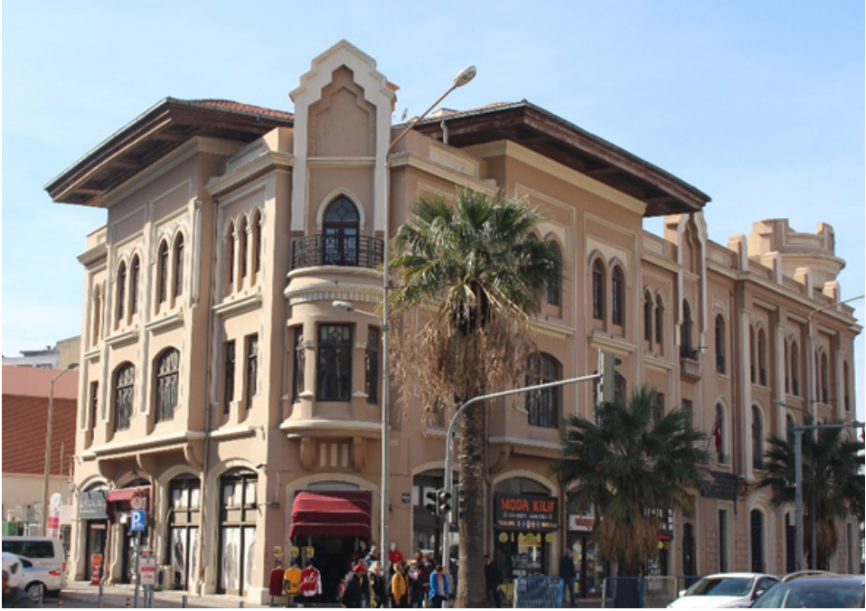
Fot. 28. İzmir Amerikan Konsolosluğu binasının genel görünümü
