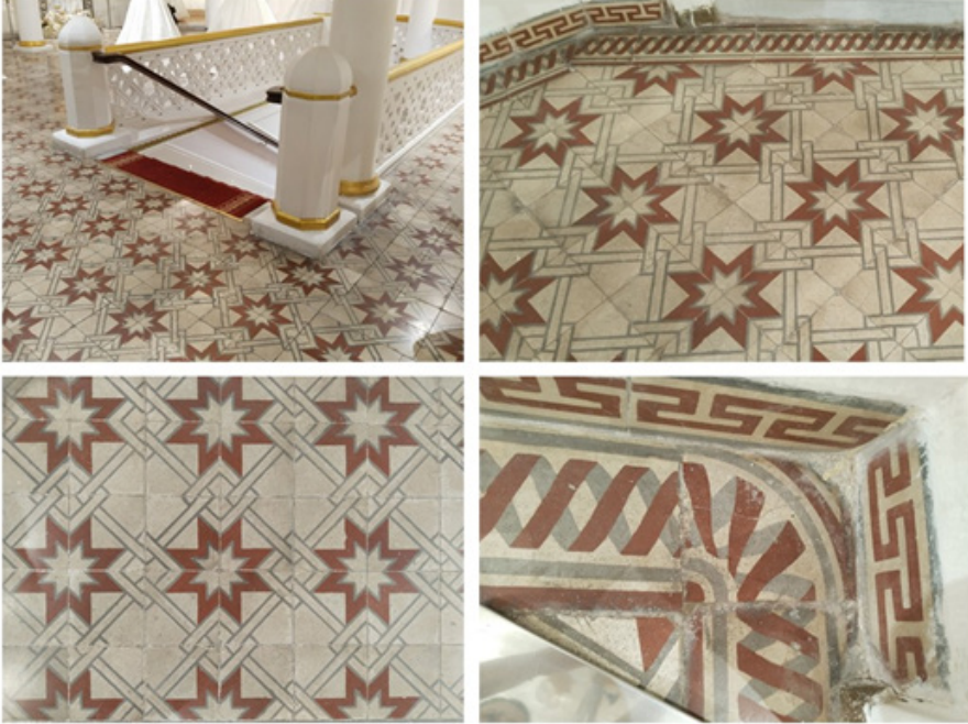
Fot. 21. Silahçiođlu Hanı'nın birinci katında yer alan zemin, bordür ve süpürgelik karoları
