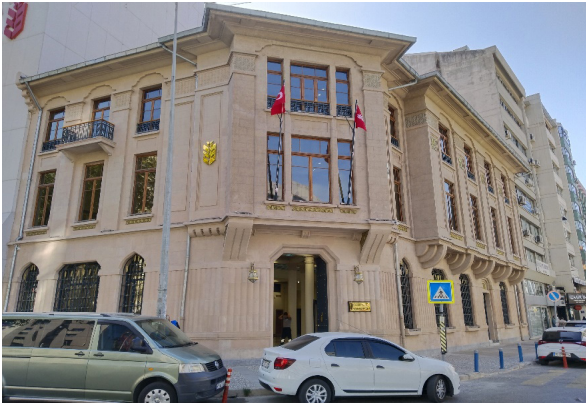
Fot. 25. Ziraat Bankası İzmir Şube binası
