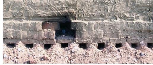
Şekil 15. Sahra Fırını Hava Kanalları.
