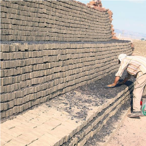
Şekil 18. Tuğlaların Arasına Kömür Serilmesi.
