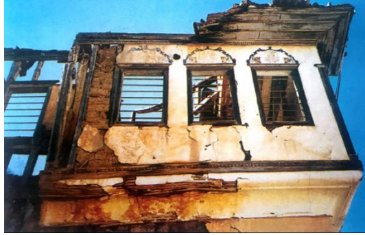
Şekil 13. Zeki Kadirbeyođlu Evi Kerpiç Duvar Örneđi, Volkan Şenel.
