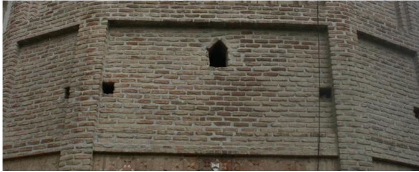
Foto 20. Dış cepheden ara kısım (Yazar Arşivi)
