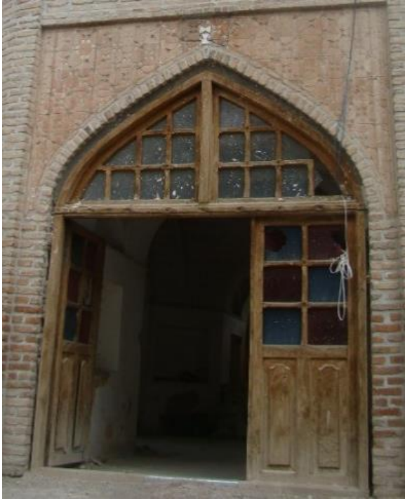
Foto 17. Giriş kapısı ayrıntı
