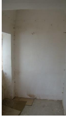
Foto 7. Eyvanın yanındaki oda
