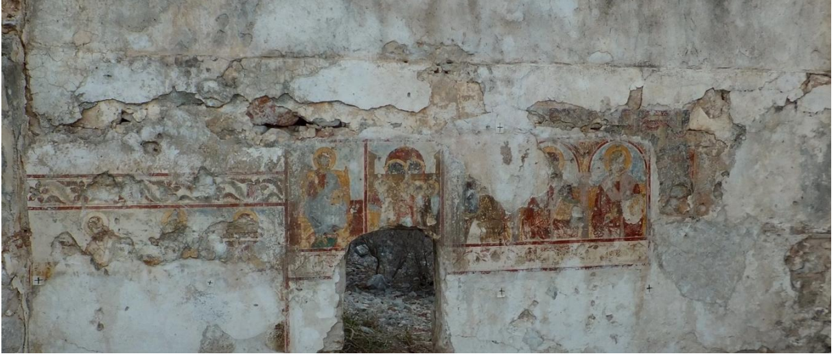
Figür 7. Naos güney duvarı
