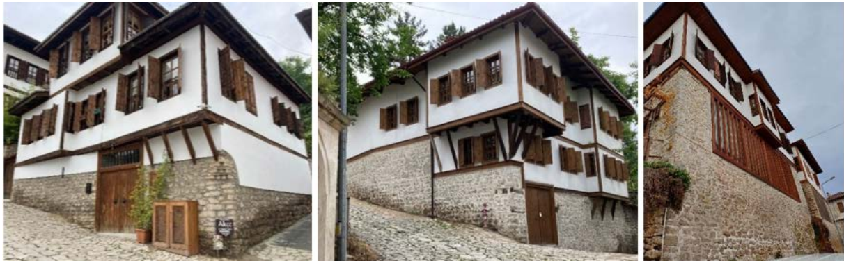
Şekil 6. Çarşı bölgesinde yapı örnekleri (Yazarın arşivinden)
