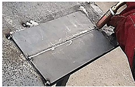
Şekil 1. Kaynak öncesi puntalanmış ve kaynak ağızı açılmış plakaların görüntüsü (Image of plates that have been centered and welding bent opened before welding)
