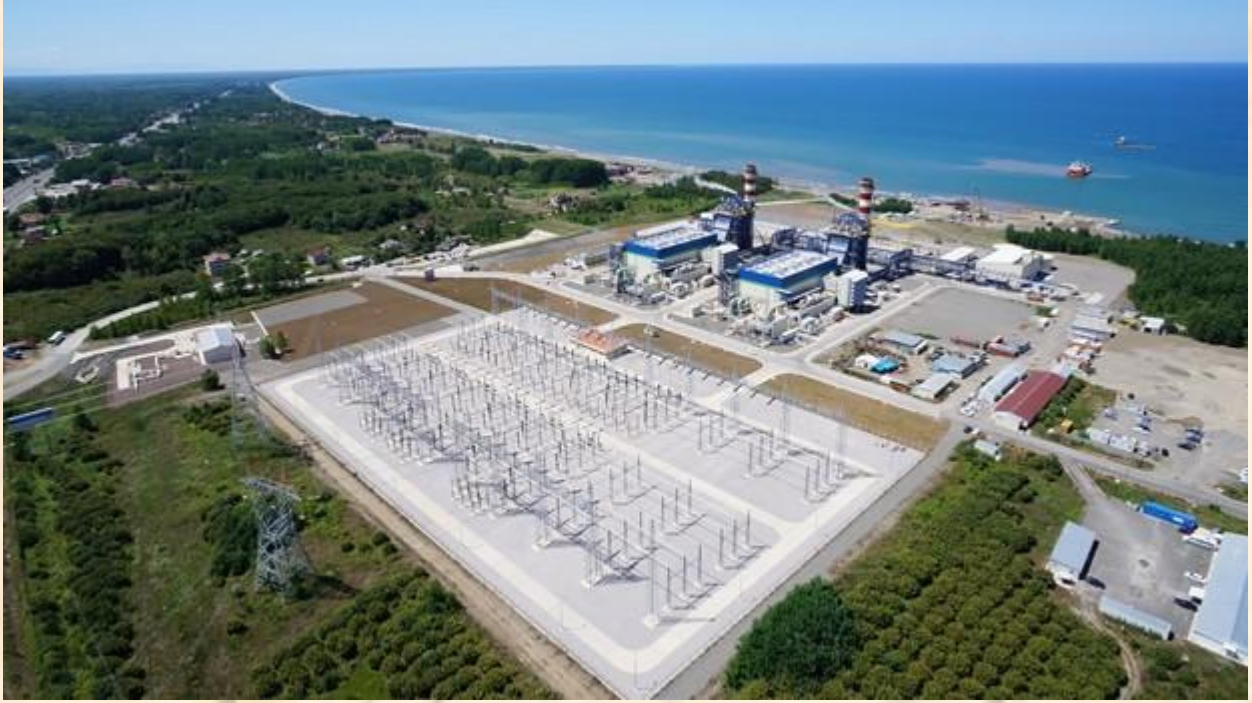
Şekil 7. Samsun elektrik doğal gaz santrali.
