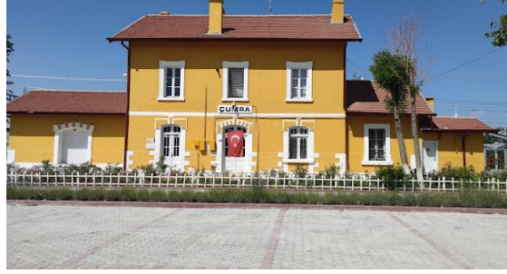
Şekil 8. Çumra Kenti ve Konya İstasyon Binaları (URL- 7)
