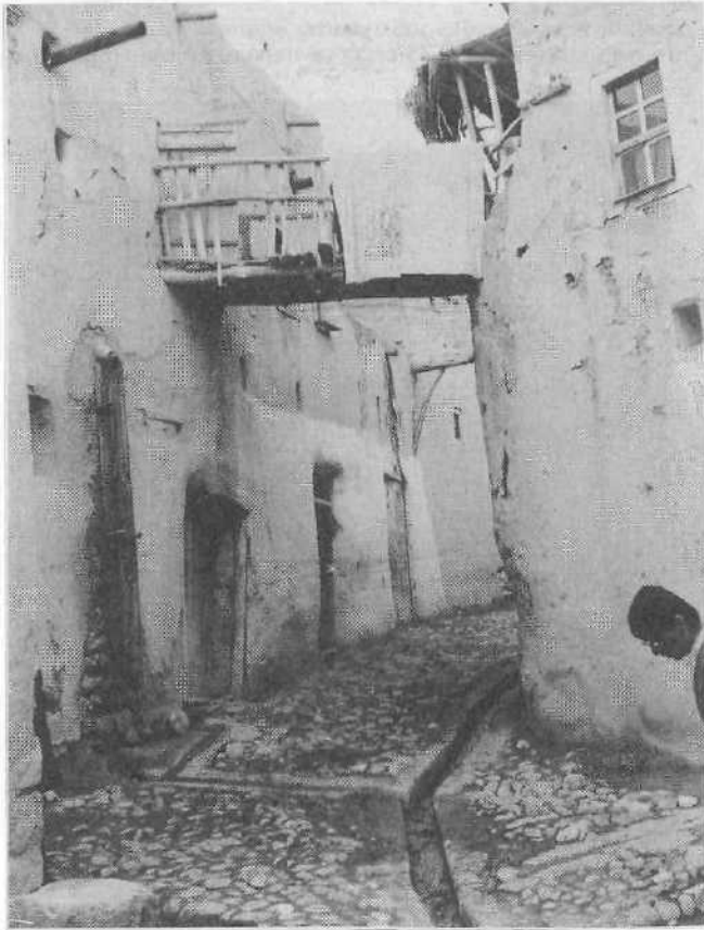
Foto 6. Balaban, la vue de geçme (le pont) entre les maisons de Duran Koçer et Niyazi Çiftçi, 1977
