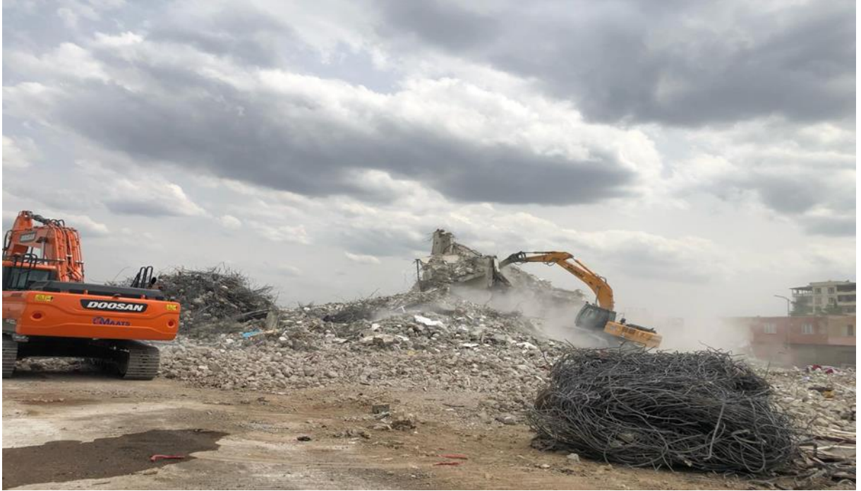
Görsel 4. Nurdağı İlçesinde Ağır Hasarlı Binanın Yıkımından Bir Görünüm.
