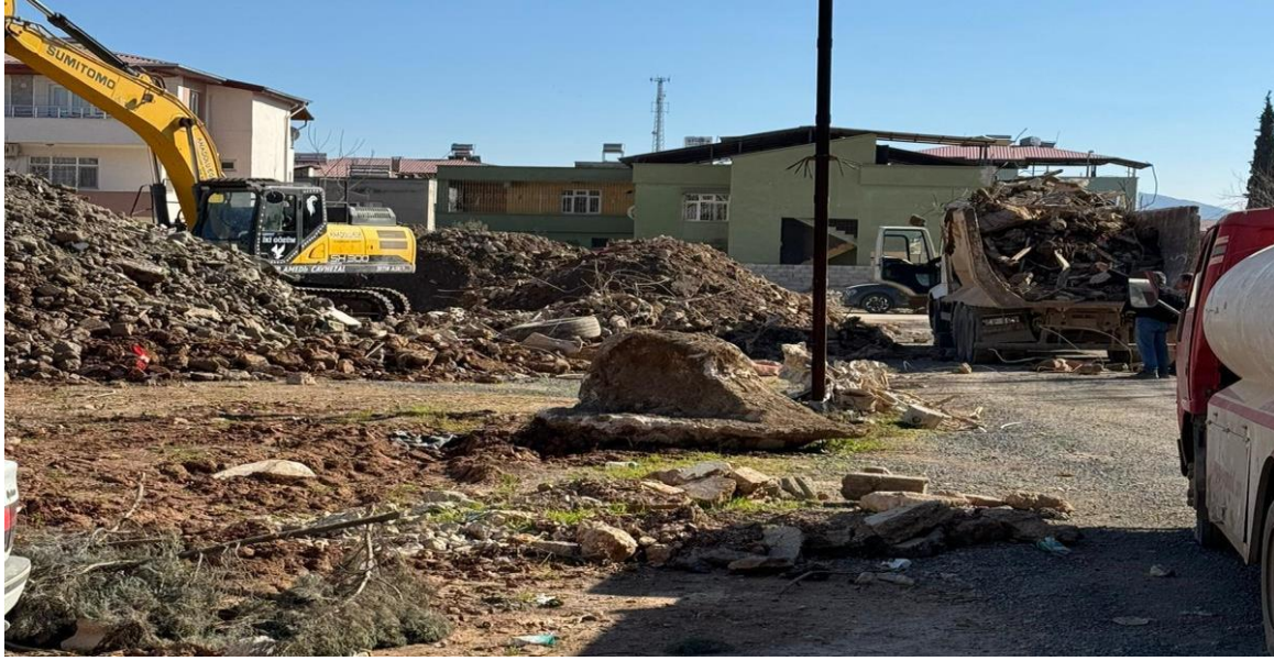
Görsel 2. Enkaz Atıklarının Yüklenmesinden Bir Görünüm (Nurdağı İlçesi)
