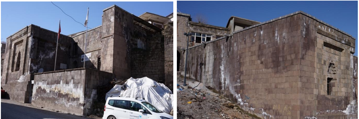
Şekil 7, 8: Medresenin güneydoğu ve güneybatı yönden görünüşü (2023, Y.T.)
