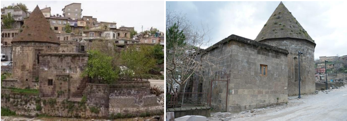
Şekil 11, 12: Memi Dede Mescidi'nin güney ve kuzey cephelerden görünüşü (2022, Y.T.)
