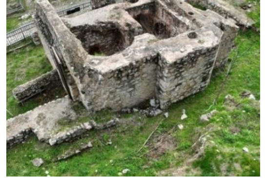
Resim 4. Kuzey cephesi görüntüsü
