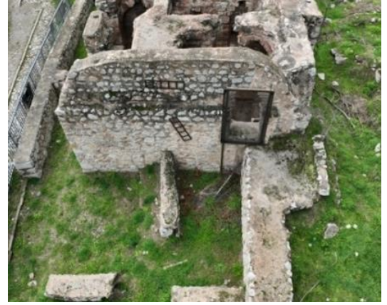
Resim 3. Doğu cephesi görüntüsü
