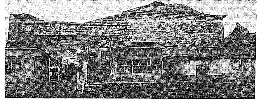
Resim 8. Arasta devamında hamam cephesi, erkekler girişi, sağda çeşme.
