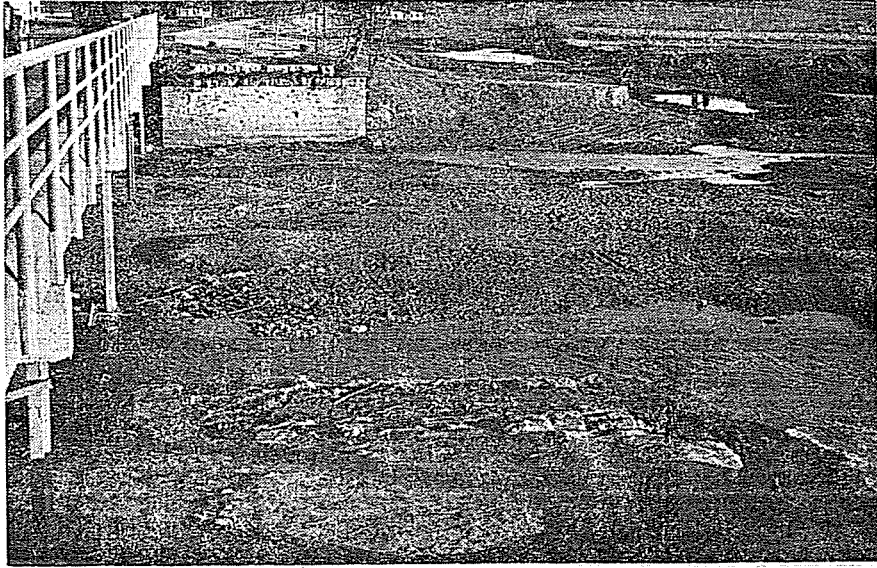
Resim 3. Modern köprü ve eski ayaklar.
