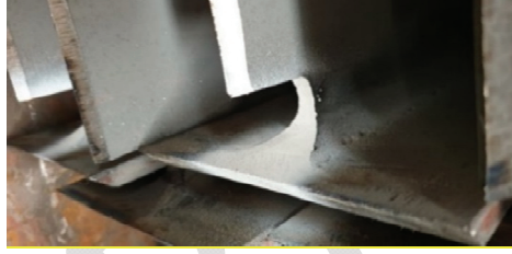
Şekil 2.5 - Kaynak erişim delikleri için penetrant test uygulaması.
