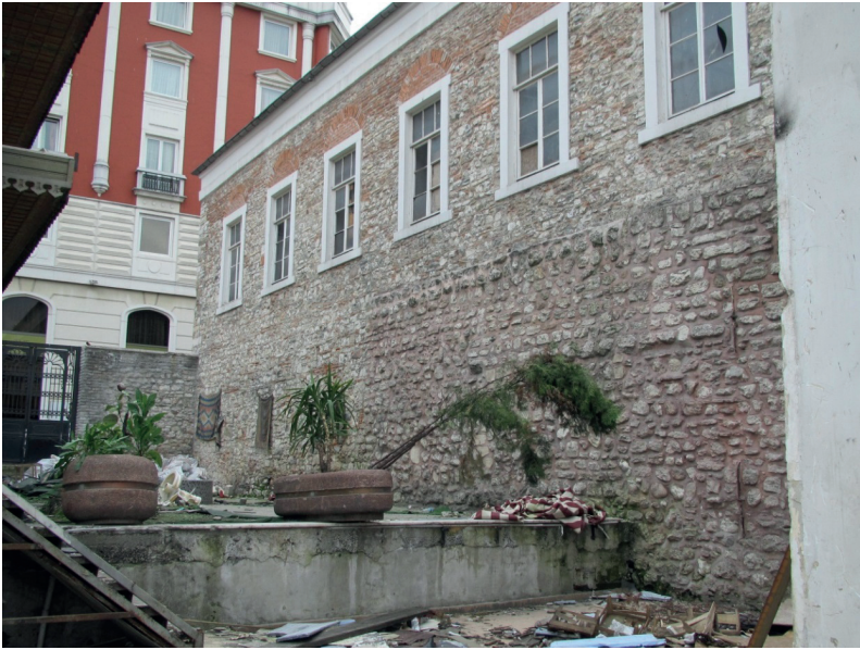
F.10- Safvetî Tekkesi'nin avluya bakan kuzeydoğu cephesi
