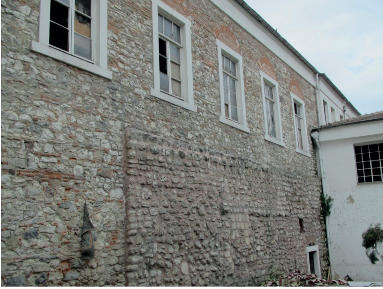
F.13- Kuzeydoğu cephede moloz taş örgülü kılıfla kalınlaştırılan kısım
