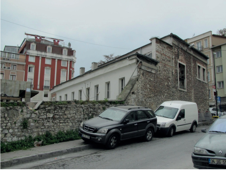
F.5- Safvetî Tekkesi'nin kuzeydoğu cephesine bitişik olan betonarme yapı
