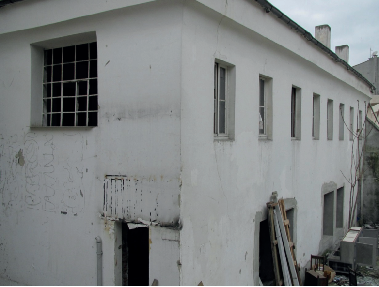
F.6- Safvetî Tekkesi'nin kuzeydoğu cephesine bitişik betonarme yapının cephe düzeni
