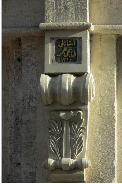
F.14- Güney cephesinde“Asitaneli Taşçı Ömer, 1320” Yazısı (2012)
