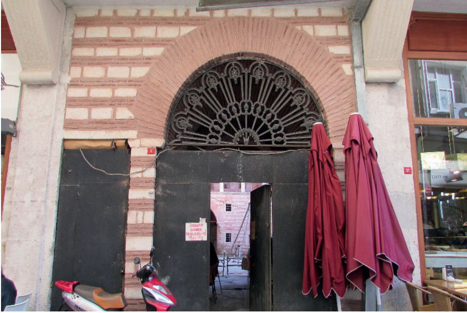
F.16- Batı cephesi giriş kapısı, (2012)
