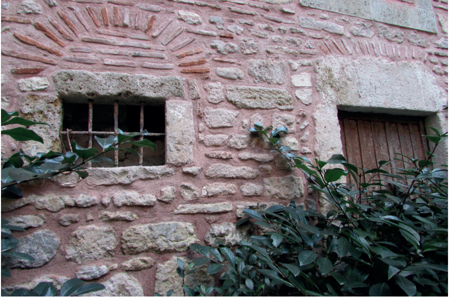
F.4- Bodrum kat pencere ve kapı örneği, (2012)
