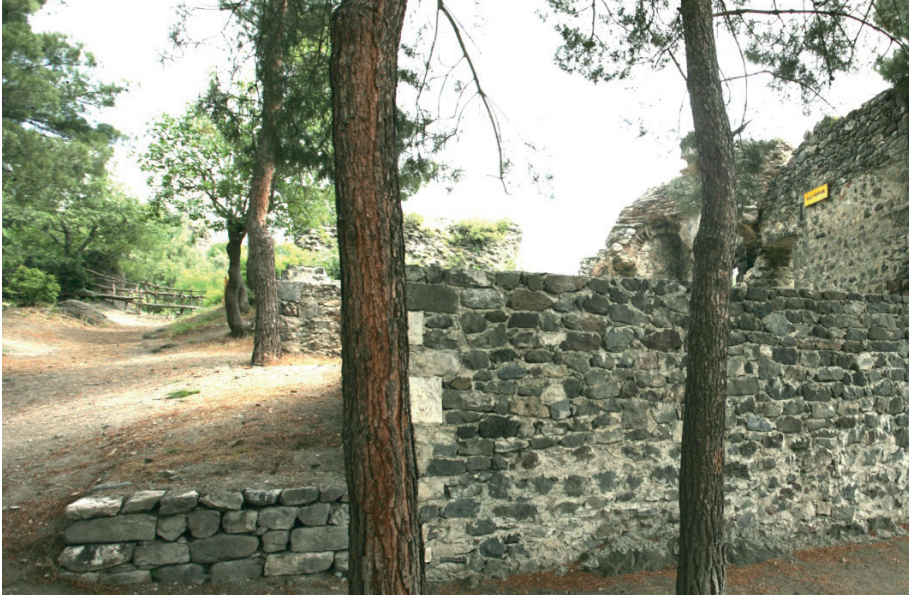
F. 22- Kale Hamamı'nın batı cephesinden bir görünüş (2012)
