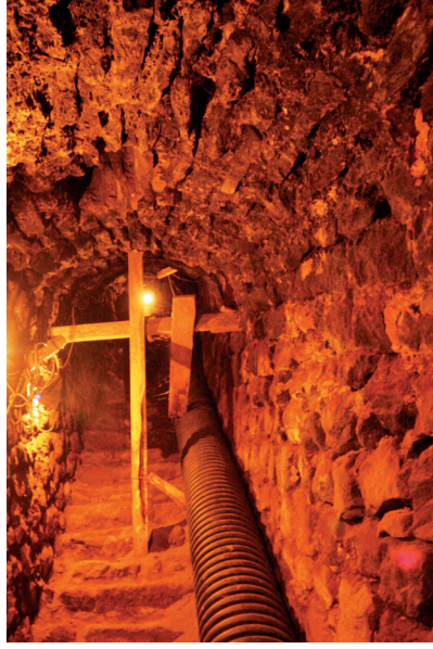
F. 19- İçinde temizlik çalışmaları sürdürülen tonozlu geçit (2012)
