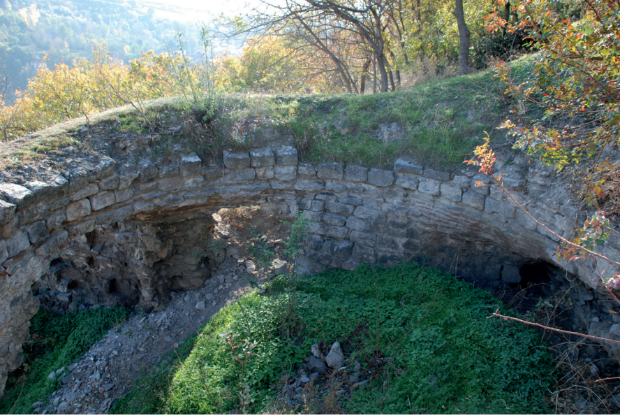
F. 25- Kilisenin yakınındaki yapı kalıntıları (2012)
