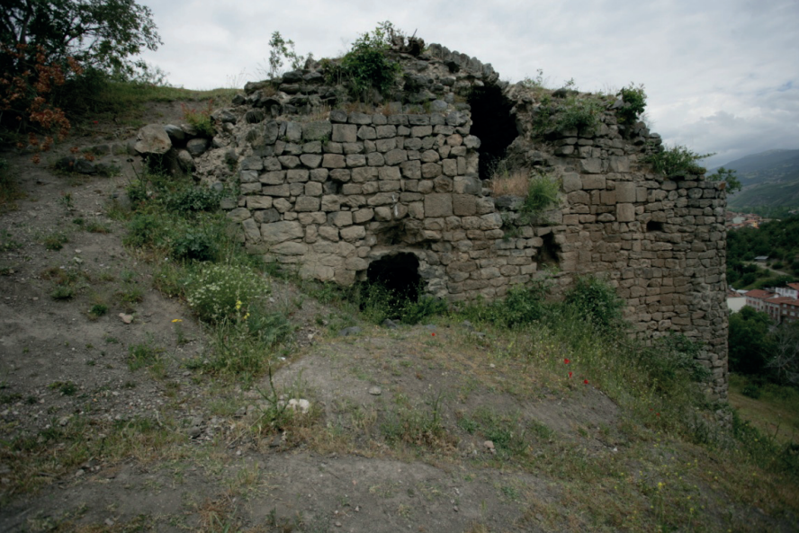
F. 26- Yapının batı cephesi (2012)
