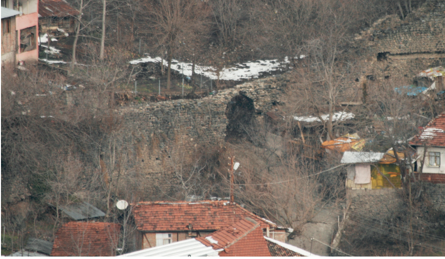
F. 13- Kale Yolu Sokağı'na açılan kapı (2012)
