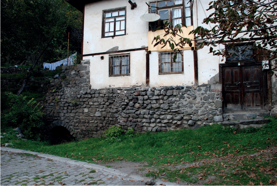
F. 18- Evin altında kalan gizli geit řeklindeki dehlizin giriři (2012)
