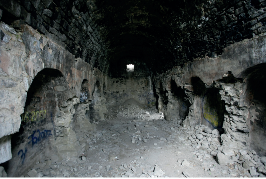
F. 27- Yapının içi ve duvarlardaki nişler (2012)
