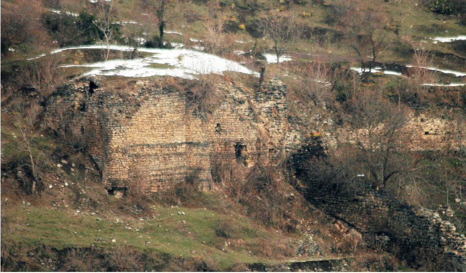
F. 28- Yapının kulelerle tahkim edilmiş güney cephesi (2012)
