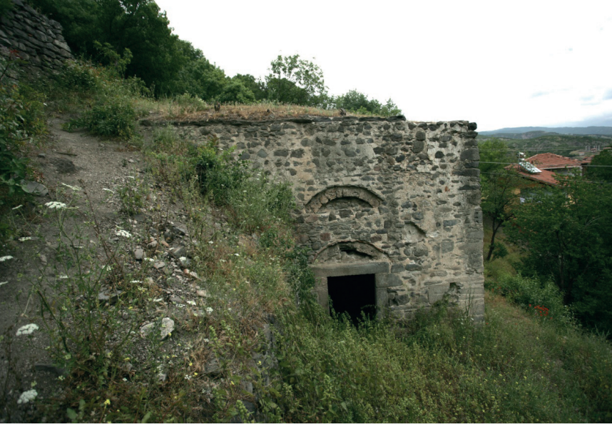
F. 23- Kilisenin batı cephesi (2012)
