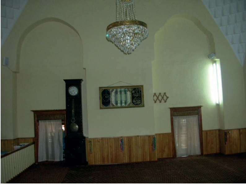
F.10- Edremit Kurşunlu Cami. Onarım öncesi harim.
