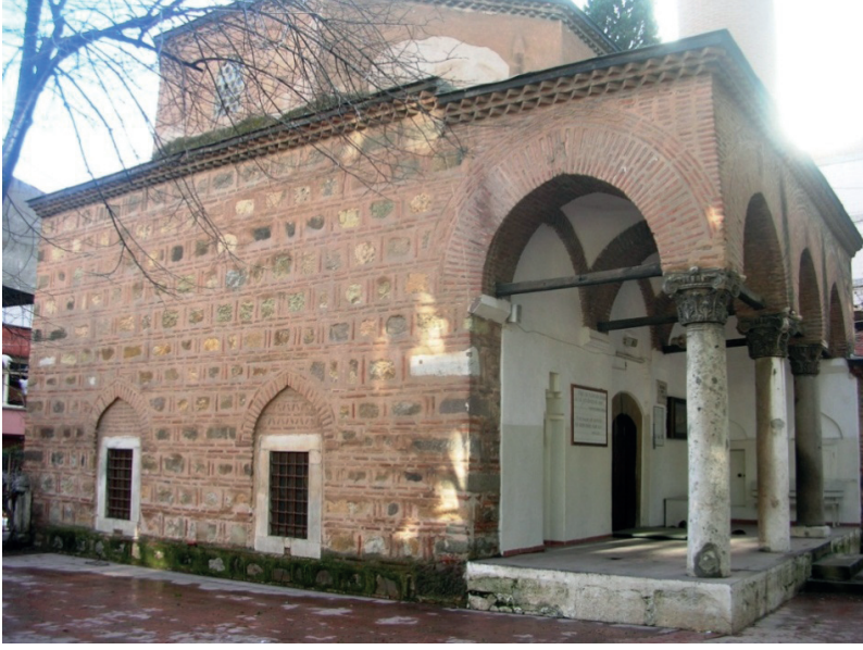
F.2- Edremit Kurşunlu Cami. Son onarımlardan önce doğu cephesi.
