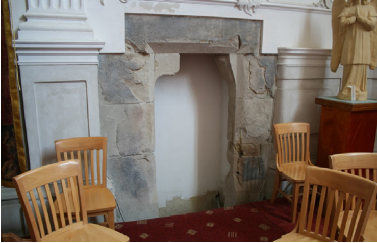
Şekil 15 Koro bölümünün kuzey duvarında ve apseye yakın konumda yer alan sonradan kapatılmış kapı.
