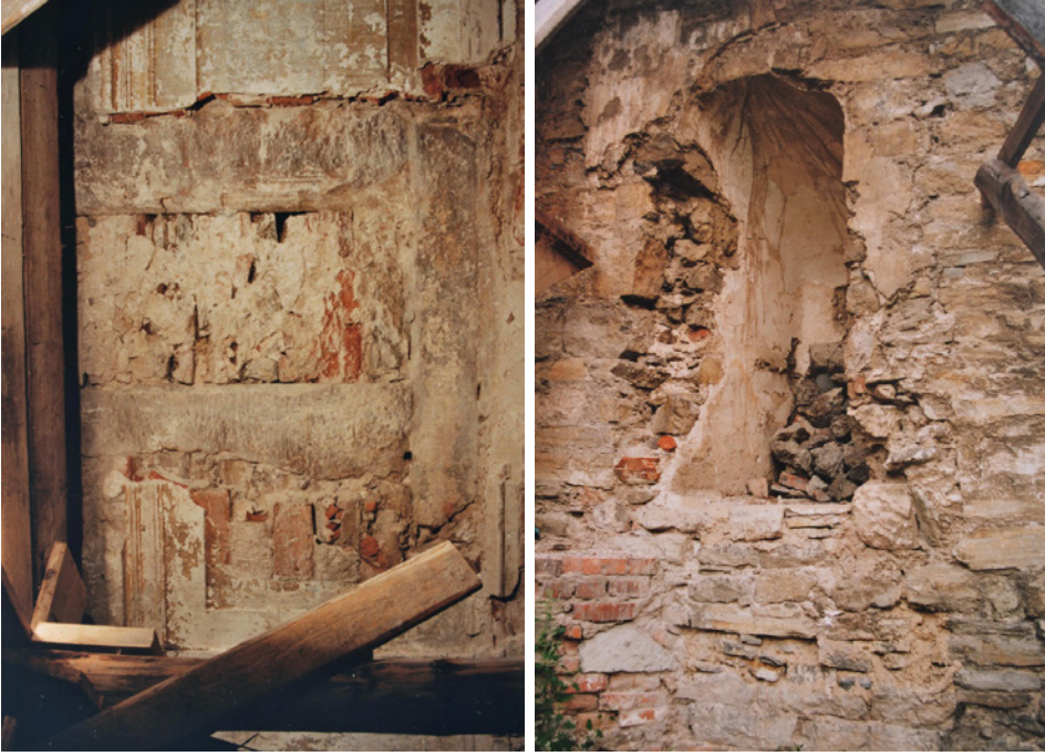
Şekil 18 2001 yılındaki restorasyonda apsis güneydoğu duvarının içten (solda) ve dıştan (sağda) görünümü (Fotoğraflar: K. Jurków ve J. Smaza).
