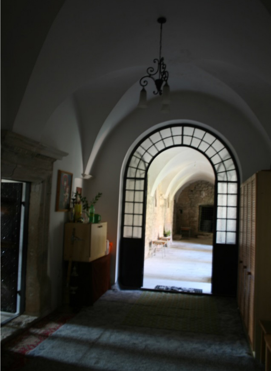
Şekil 17 Kiliseden manastıra geişi sađlayan apraz tonozlu blm.
