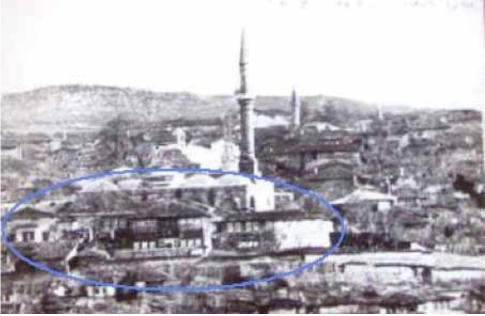
Resim 5: Muradiye Mevlevîhanesi, genel görünüş (S.Ünver, Defter No:59, s.1)
