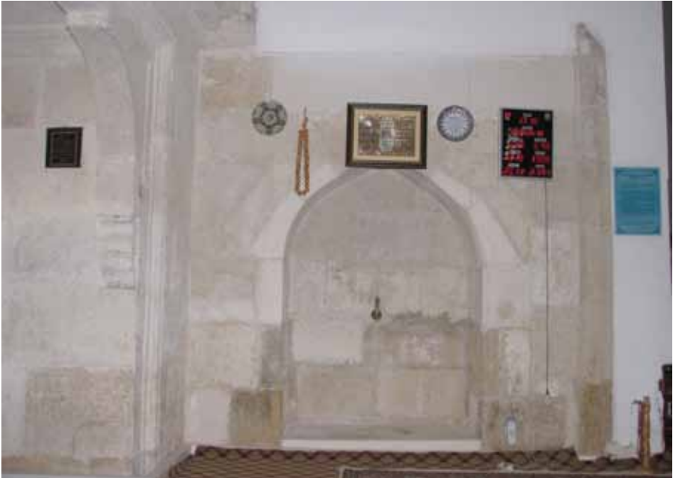
Resim 10: Restorasyon sonrası ortaya çıkarılan duvar çeşmesi (2005)
