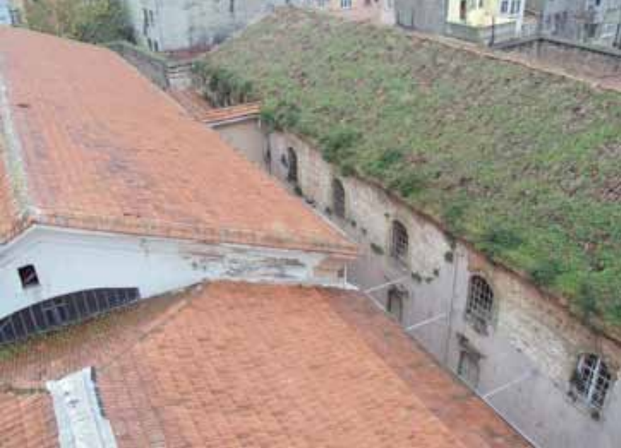
Şekil 34: Kuzeybatıdan Vortvots Vorodman Kilisesi beşik tonozu – Restorasyon öncesi Solda Surp Asdvadzadzin Patrikhane Kilisesi çatıları (K. Özkaragöz Arşivi)
