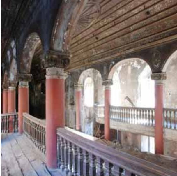
Şekil 20: Galeri katı - kemer dizisi ve tonoz - Restorasyon öncesi (M. Çıtak Arşivi)
