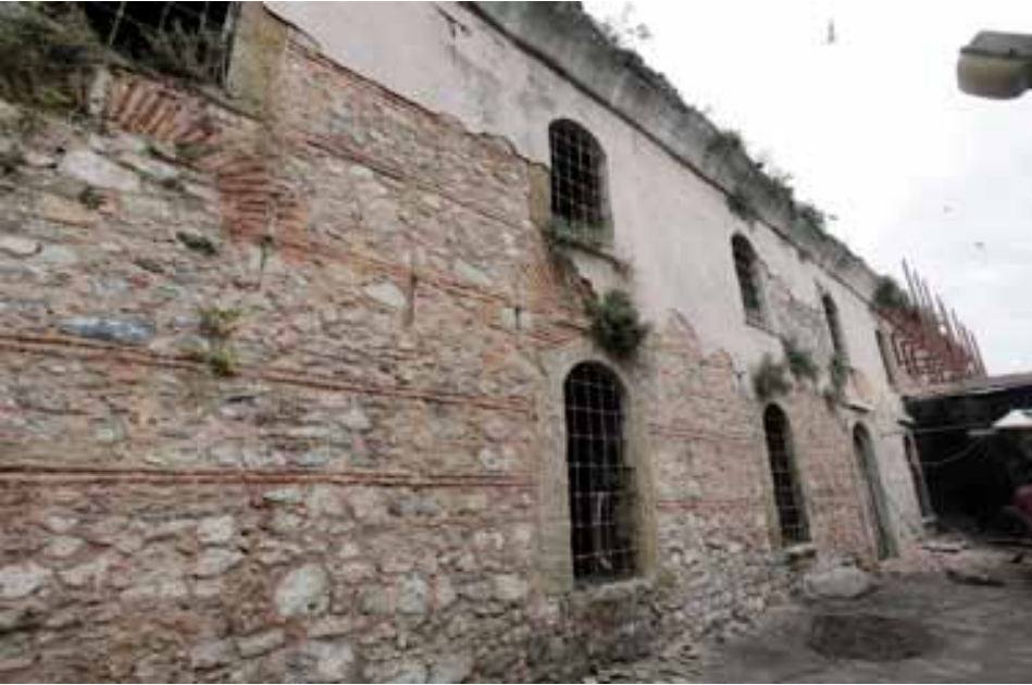
Şekil 32: Güney yan cephede örülmüş pencere açıklığı – Restorasyon (K. Özkaragöz Arşivi)
