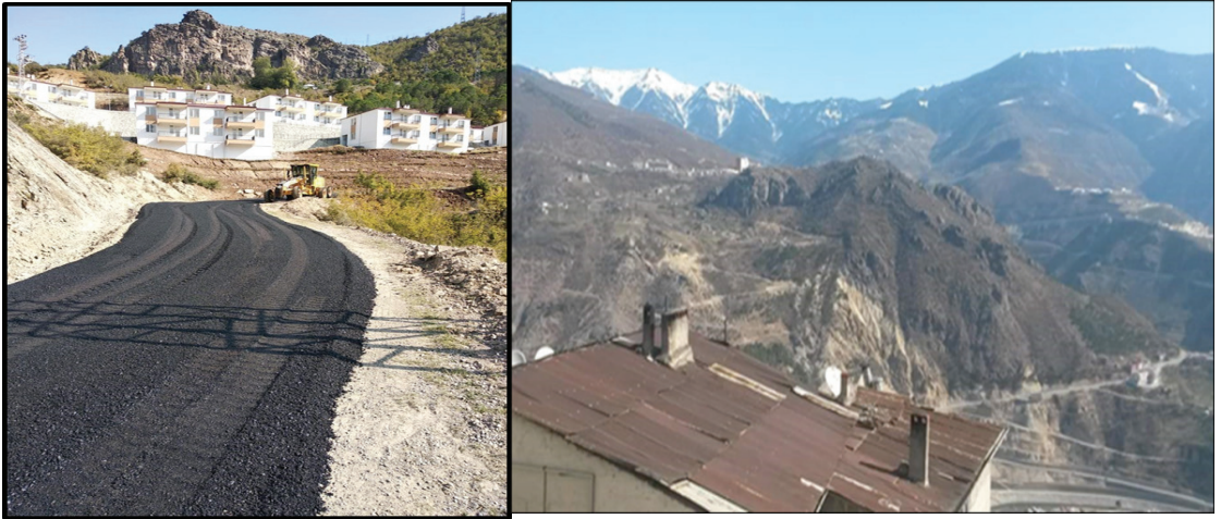
Şekil 12. Artvin şehir merkezinden Seyitler Köyü Carbiyet Mahallesi ve kaya düşmesi kaynak alanının görünümü.
