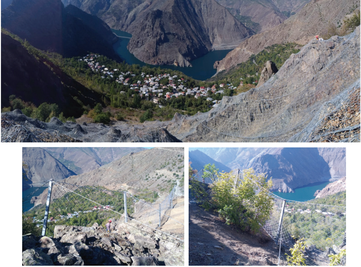
Şekil 8. Demirkent köyündeki kaya ıslahı çalışmalarının görünümü.
