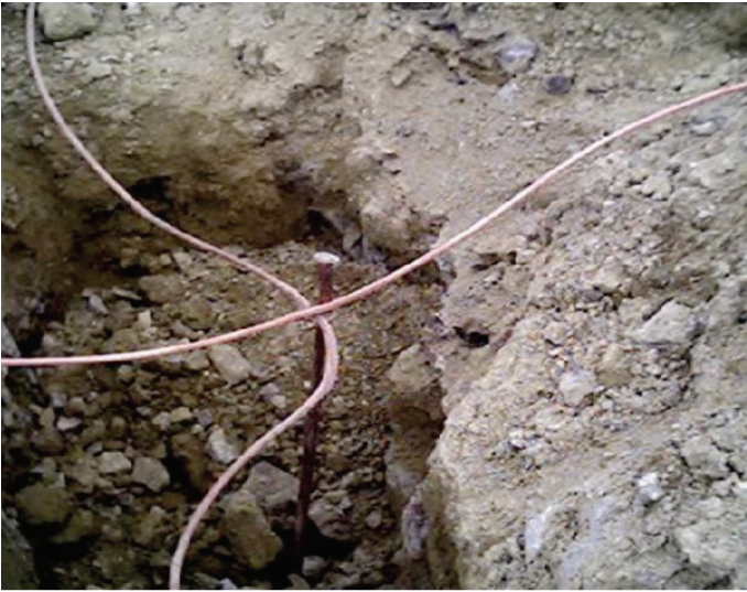
Şekil 1. Yüksek gerilim şalt sahası topraklama ağı
