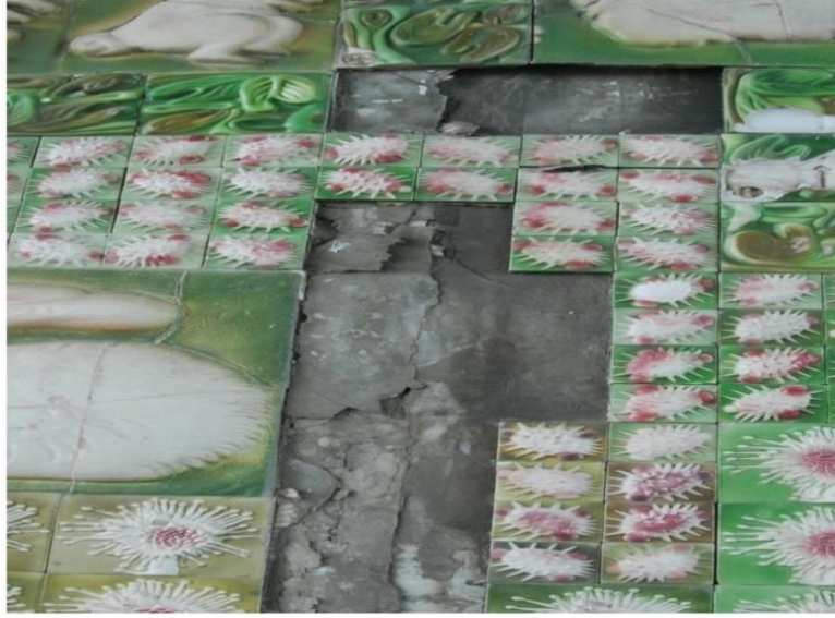
Şekil 15. "Angora Tavşanı ", Karışık teknik, 25x3.50 mt, 2009, Ankara. (Kamusal alan, köprü altı sanat projesi uygulama alanı, duvarın arka yüzünden su ve nem almasıyla ön yüzeyden dökülen seramik pano örneği detay. Fotoğraf; Kamuran KARAAĞAÇ arşivi)
