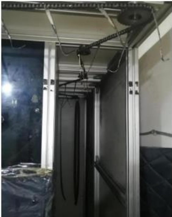
Şekil 3. Kurutma fırınının önceki hali
