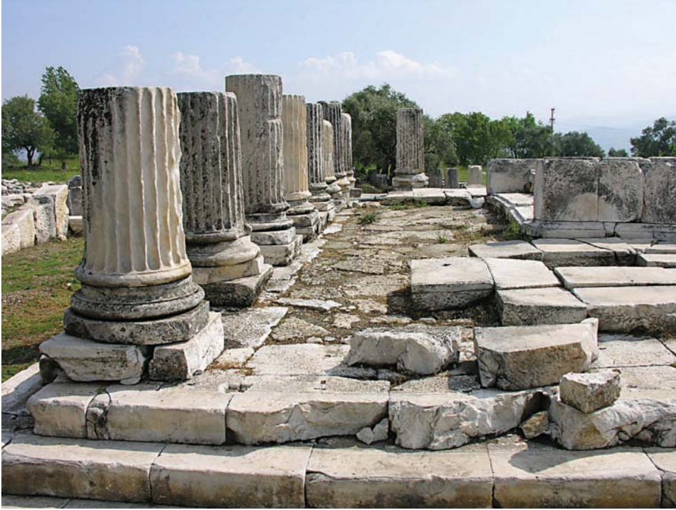
Resim 4: Tapınađın Alt Yapısında Kullanılan Konglomera ve Mermer Bloklar
