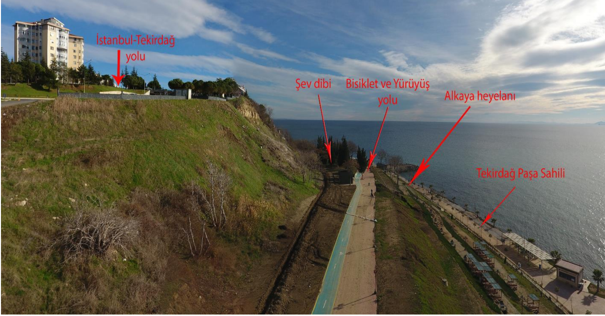
Şekil 9. Alkaya heyelanının meydana geldiği yamaç arazide yanlış arazi kullanımı görülmektedir.
