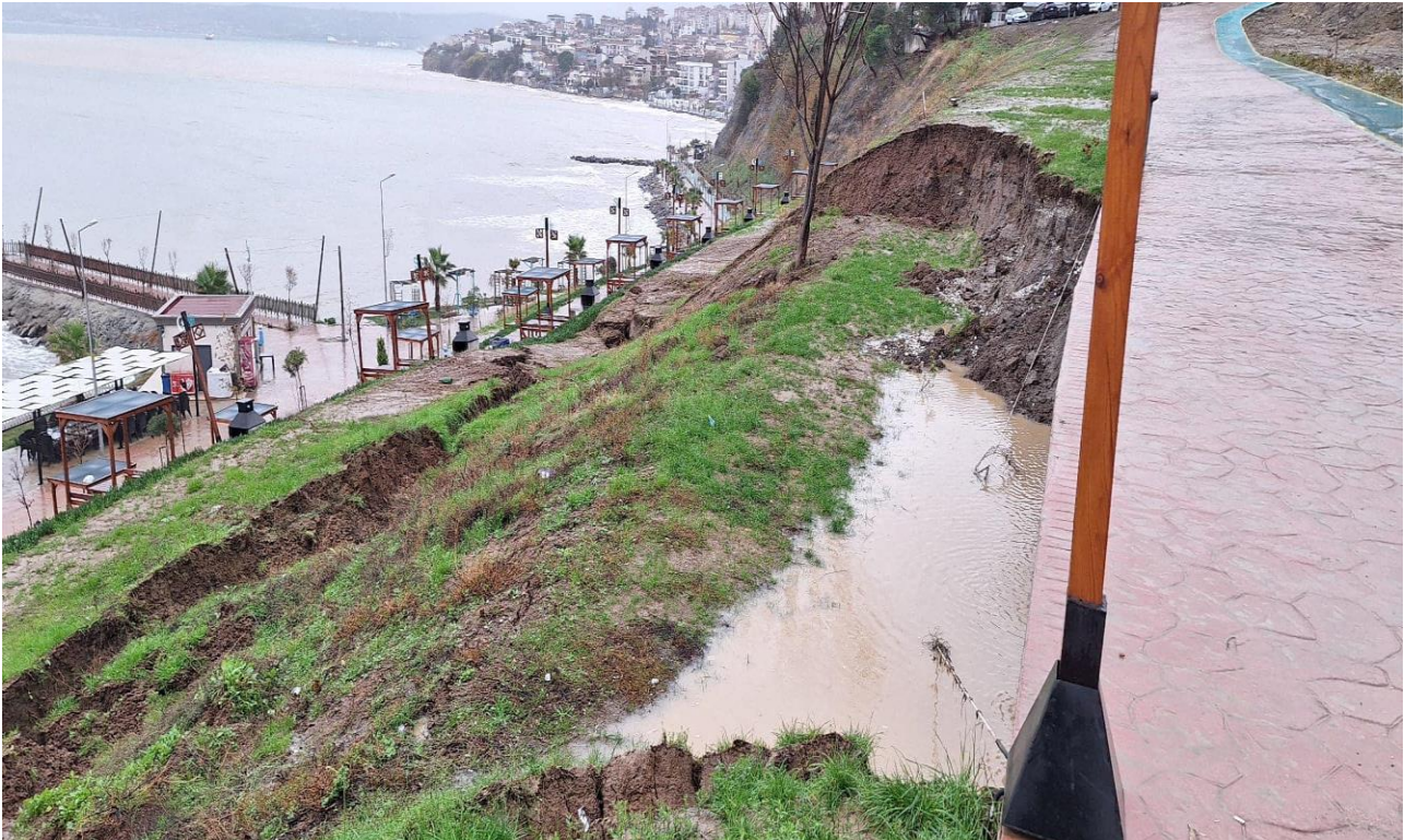
Şekil 10. Alkaya heyelanının meydana geldiği yamaç arazide yağışlarla gelen suyun şev diplerinden sızması, alttaki anakanın su içeriğinin artmasına ve sürtünmenin azalarak heyelanın oluşmasına sebebiyet vermiştir (Gence, 2023)
