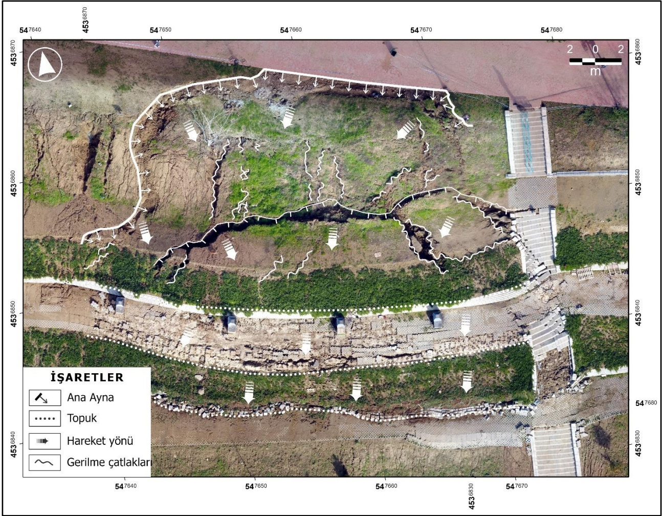
Şekil 3. İnceleme alanındaki Alkaya heyelanının orto-foto görüntüsü
